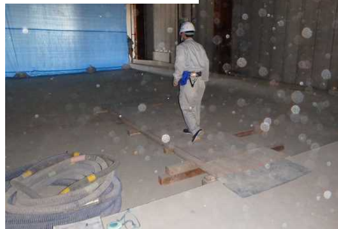
【段差解消-スロープの設置】
