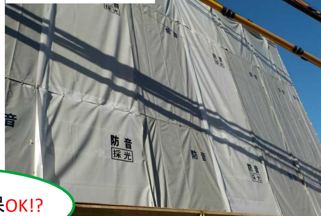
【採光防音シート設置】
