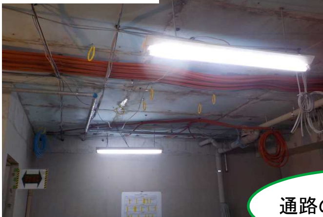
【棒状蛍光灯照明設置】
